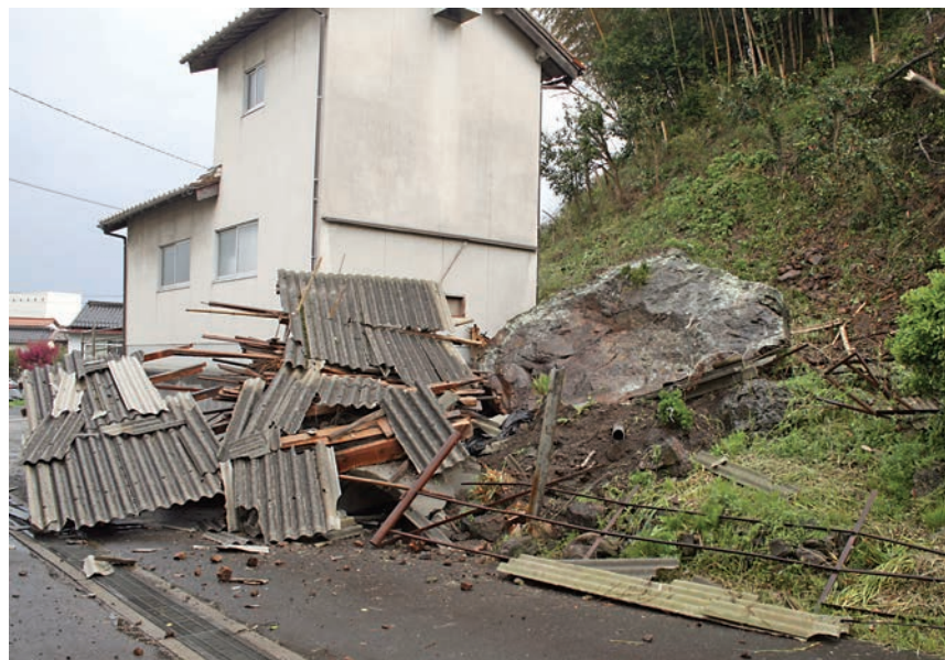
▲大田市內有約16棟建築物在地震中損壞 共同社
