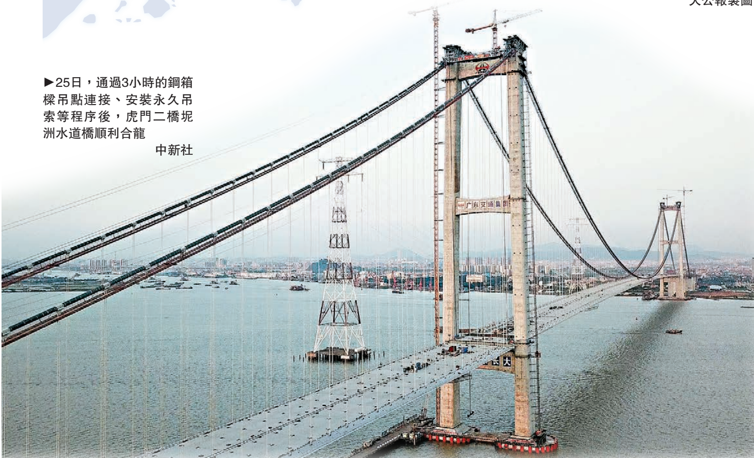
▲橋樑工人在虎門二橋合龍前進行最後一塊鋼箱樑的焊接 中新社
