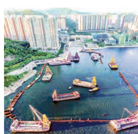
在填海工程範圍設置臨時鋼圍堰，可減少挖泥時對附近水域造成的影響，同時提升施工安全。
