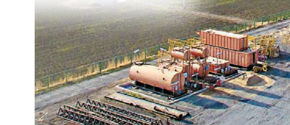
▲6月2日，中國超級鑽機「地殼一號」正式宣布完成首秀，以完鑽井深7018米創亞洲新紀錄。圖為「地殼一號」整機系統
