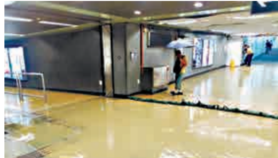
▲港鐵鑽石山站一個入口，被地盤黃泥水倒灌積成潭
