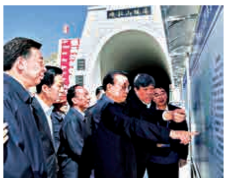
▲26日，李克強在西藏山西省川藏鐵路拉林段施工現場，考察勘探設計和施工進度。中國政府網
