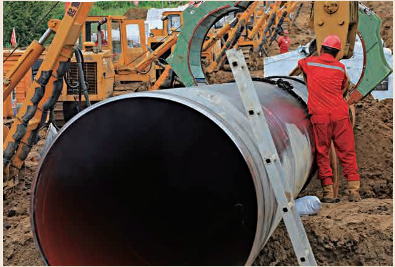
大口徑的中俄東線天然氣管道能提升輸送量，預計明年建成 大公報實習記者鄭雲風攝
