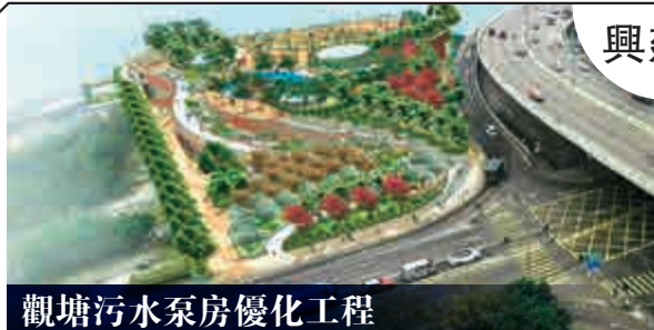
觀塘污水泵房優化工程
