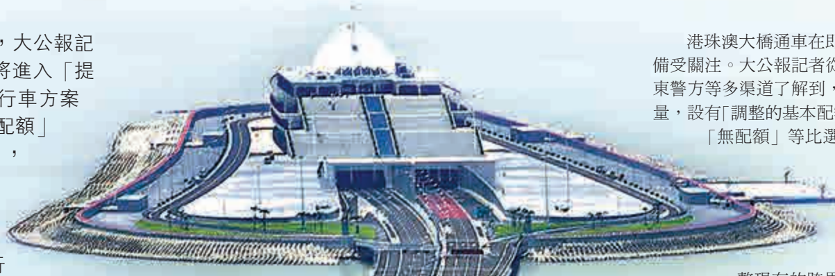
▲港珠澳大橋的東人工島預留旅遊觀光功能，定位為「景觀島」
