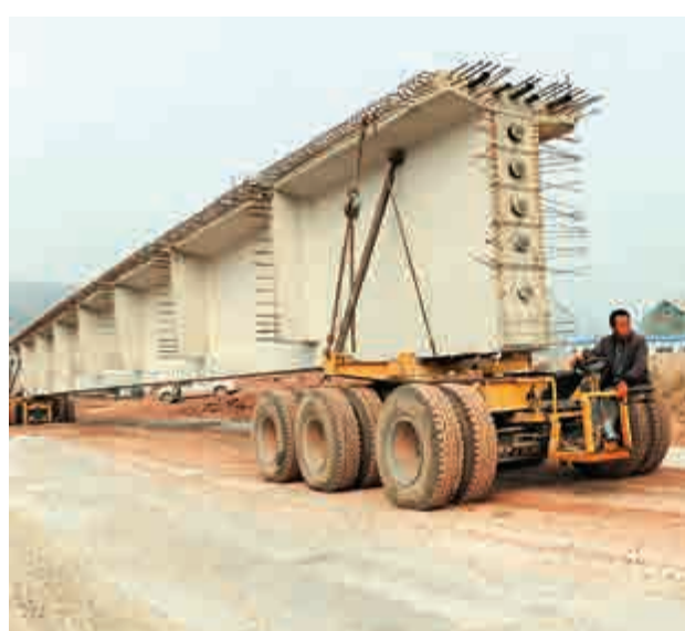
▲邢台渡口大橋施工現場一角
