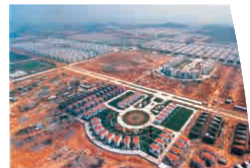
▲早期規劃建設中的祈福新邨 受訪者供圖
