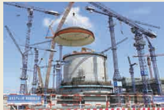
▲正在建設中的「華龍一號」示範項目廣西防城港3號機組 受訪者供圖
