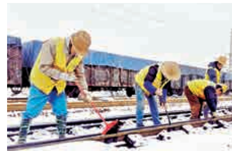
▲雲南曲靖工務段線路工人清除鐵道上的積雪 楊永全攝
