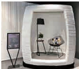
▲3D混凝土打印的涼亭，整個建造過程只需約三小時
