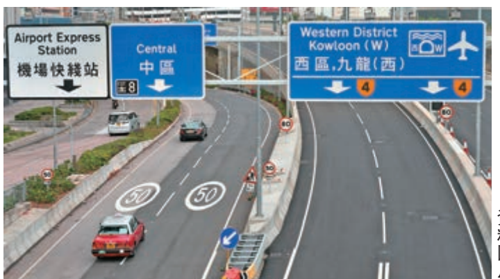
▲中環灣仔繞道西行出口工程大致完成，據悉最快下周日可開通 資料圖片
