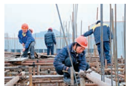
▲ 建築工人在工地現場施工
