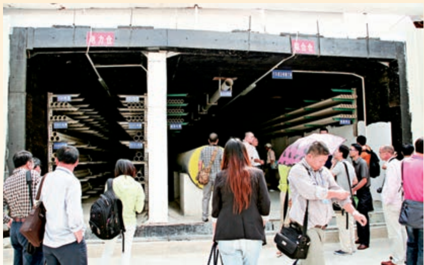
▲福建平潭地下綜合管廊或者可以成為兩岸「新四通」的構想。左邊為電力倉；右邊綜合倉，有巨型給水管道、直飲水管道、通信電纜管道
