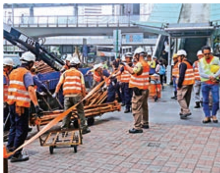
▲ 港鐵員工搬運大量金屬支架進入中環站
