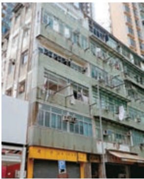
▲大角咀福澤街24至30號永發大樓早前發生火警
