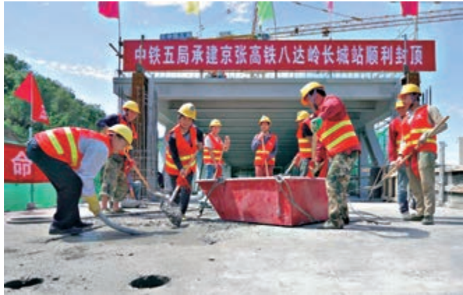
▲23日，京張高鐵八達嶺長城站主體結構正式封頂 中新社
