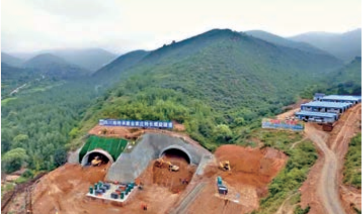
▲圖為2017年延崇高速金家莊特長螺旋隧道施工現場 資料圖片
