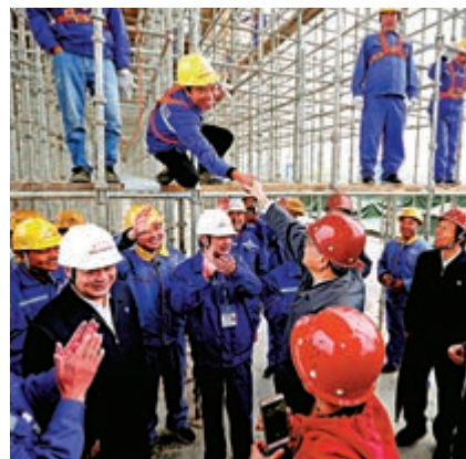
▲15日，李克強來到銀西高鐵施工現場考察。
