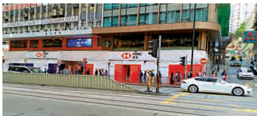
▲北角滙豐銀行分行進行裝修工程，圍板竟豎立在行人路上
