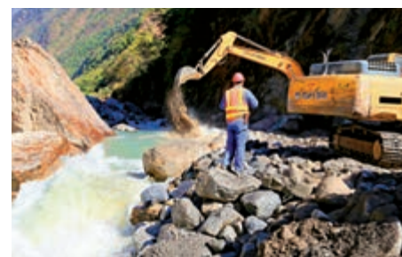
2018年12月15日，尼泊爾上博迪克西水電站修復項目實現導流工作。資料圖片
