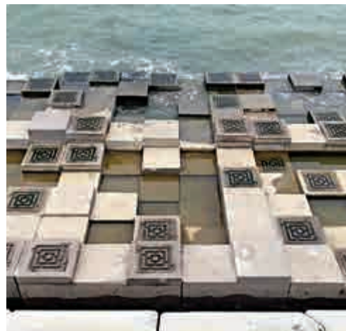
▲生態磚表面粗糙，酸鹼值偏低，有利生物生長，凹位可在潮退時蓄水，提供合適海洋生物繁殖的環境
