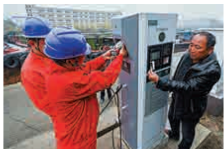
▲12月25日，在浙江長興縣呂山鄉水上服務區，工作人員幫助船主將船用輸電線接入岸電充電樁
