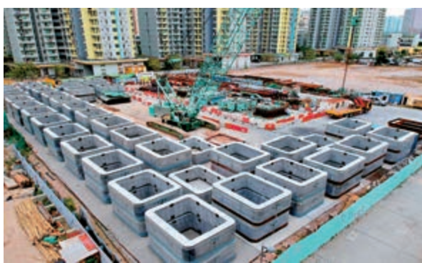
▲在地面造好的環狀預製組件將逐一吊入地底，配合鑽頭的鑽挖一環一環往前推進，形成隧道永久結構
