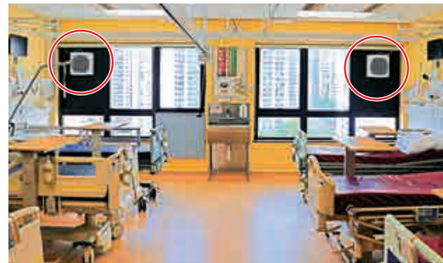
▲聯合醫院將普通病房改裝成六床位的負氣壓隔離病房，全靠加裝抽氣扇（紅圈示）
