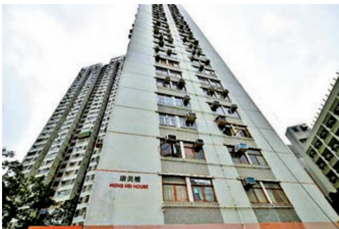
▲裝修佬早前為全港多個與康美樓同屬Y2型的屋苑免費檢查及維修排氣管 資料圖片
