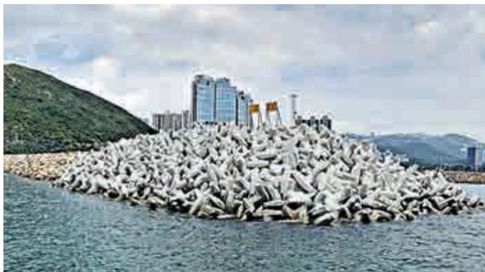
▲香港仔南避風塘的防波堤改用「弱波石」加固 發展局圖片
