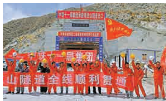
▲2018年4月7日，中鐵十一局施工人員慶祝拉薩至林芝鐵路嘎拉山隧道工程貫通 新華社
