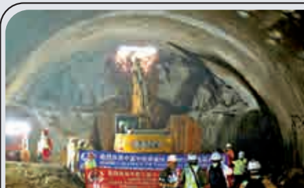
3月12日 ●5號隧道順利貫通，全長422米
