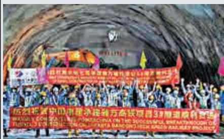
4月26日 ●3號隧道順利貫通，全長735米
