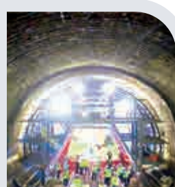
11月15日 ●7號隧道順利貫通，全長1285米
