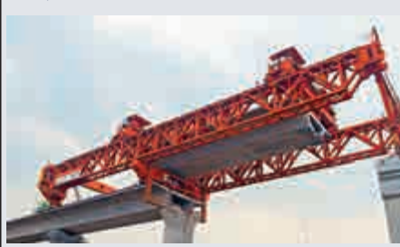
9月3日 ●4號樑場一樑樑箱樑精準成功架設，雅萬高鐵路萬隆段正式進入全面箱樑架設階段
