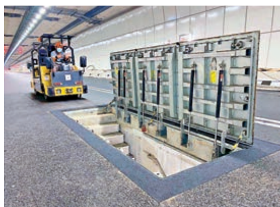
▲赤鱗角隧道內部及公用設施走廊入口
