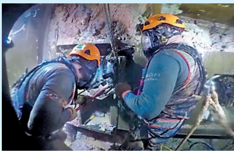
▲專業工程人員在海床底下更換鑽挖機刀頭
