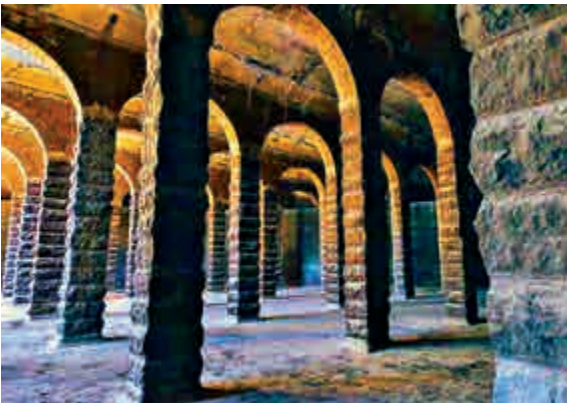
▲香港測量師學會建議主教山蓄水池完成鞏固工程後，可有限度開放予公眾參觀。
