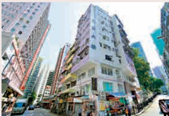
◀「共·融舍」單位設於上環高陞大樓。
