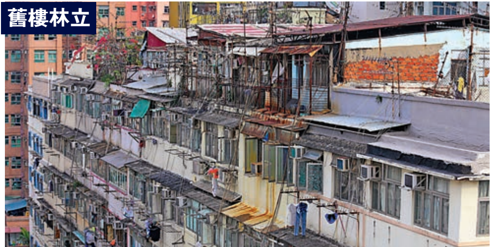
油尖旺區舊樓眾多，劃房林立渠管亂駁，衛生環境相當惡劣，早就成為病毒傳播的溫床。
