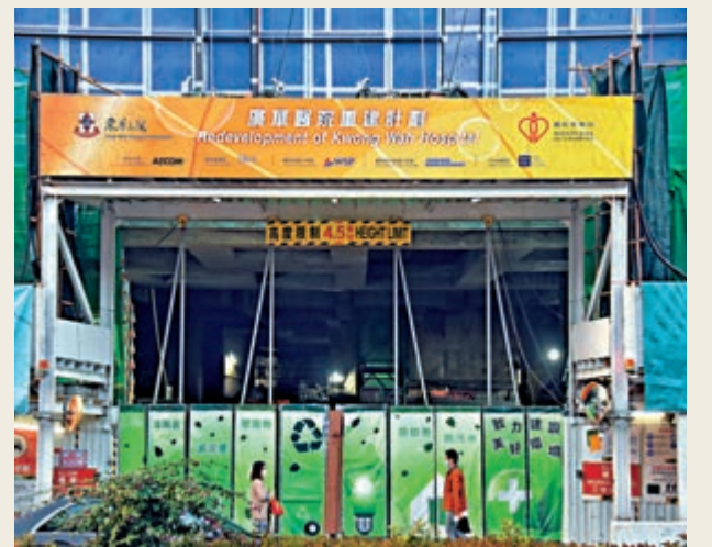
▲廣華醫院重建地盤約有四百人工作，部分工人已獲送到檢疫中心隔離。中通社
