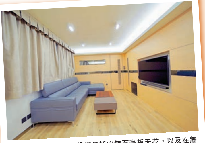
設計上常見的隔音設備包括安裝石膏板天花，以及在牆身位置使用木廊圍身等。受訪者提供
