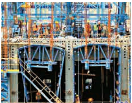
▲工人在湄洲灣跨海大橋上作業。網絡圖片
