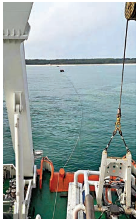
▲施工單位在海南文昌海面鋪設海纜。
