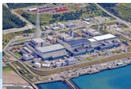
▲位於新潟縣的柏崎一刈羽核電站。
