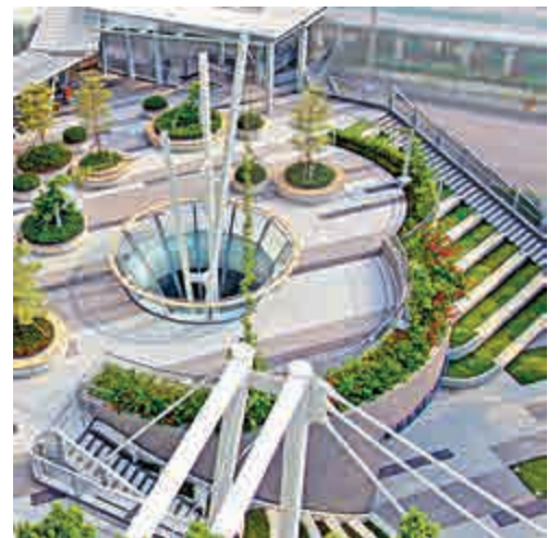
▲ 建築署以創新設計重建荃灣西樓角花園，包括把半個公園「升高」，興建一個平台花園，並在平台下興建活動中心。
