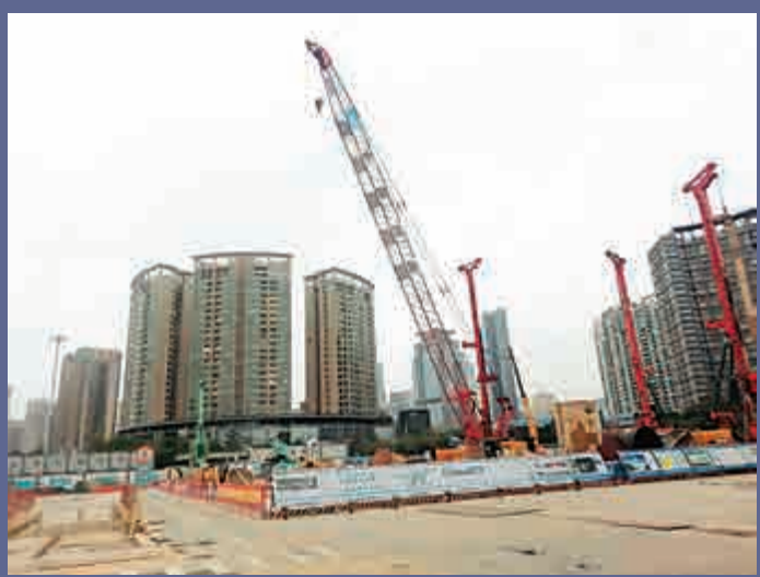
▲新皇崗口岸綜合業務樓正在加緊施工。大公報記者李昌鴻深圳攝
