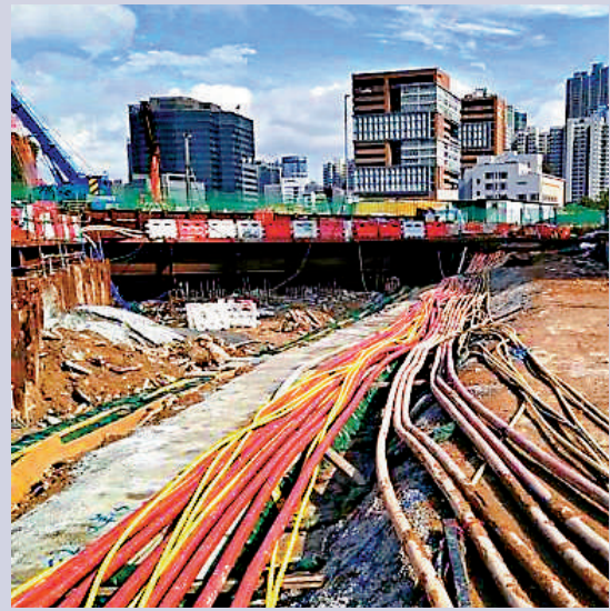
▼中九龍幹線工程地下滿布公共設施管線，建造空間狹窄。
