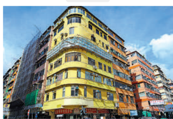
▲因樓齡高，部分唐樓在修葺。
