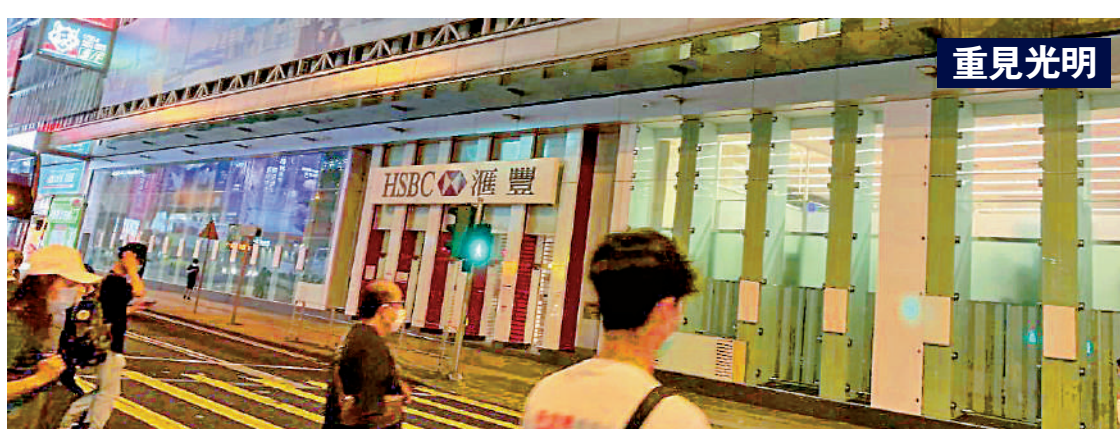
▲滙豐銀行旺角分行拆卸圍板，並完成玻璃外牆維修及改善工程。
