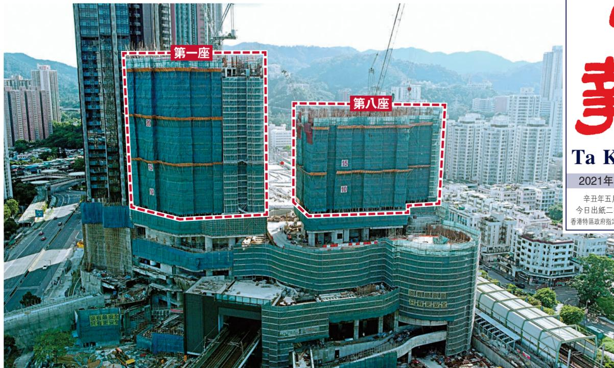
柏傲莊III第一座及第八座牆身底座部分混凝土強度未達標，發展商決定拆卸重建(紅框)。
