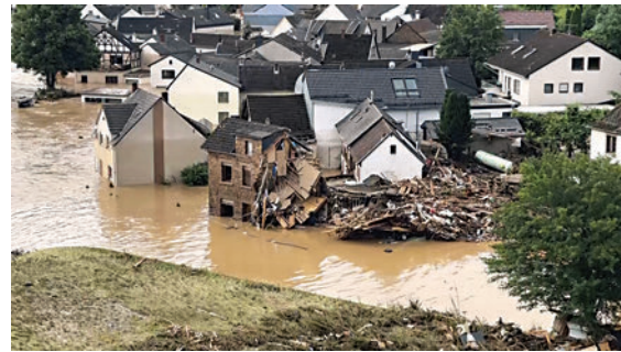
▲德國西部15日遭遇洪災，多處房屋垮塌。美聯社
