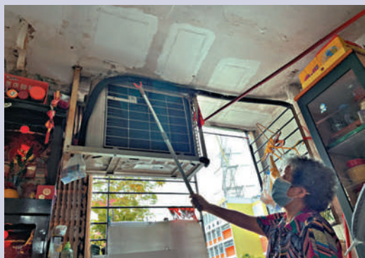
▲單位經常要維修，四處都是修修補補的痕跡。
