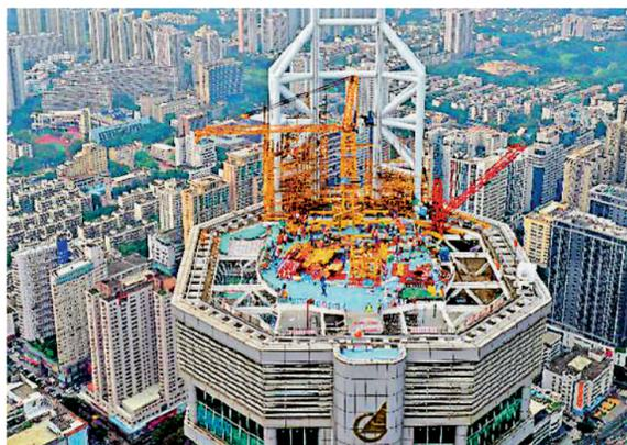
▲賽格廣場大廈樓頂安裝塔吊，進行桅杆拆除準備工作。網絡圖片
