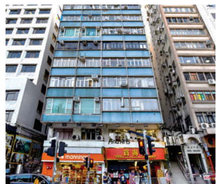
▲太極大樓樓高12層,樓齡超過50年,具重建價值。
